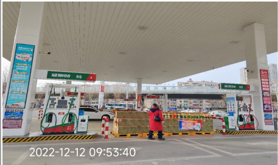
现场勘查照片
